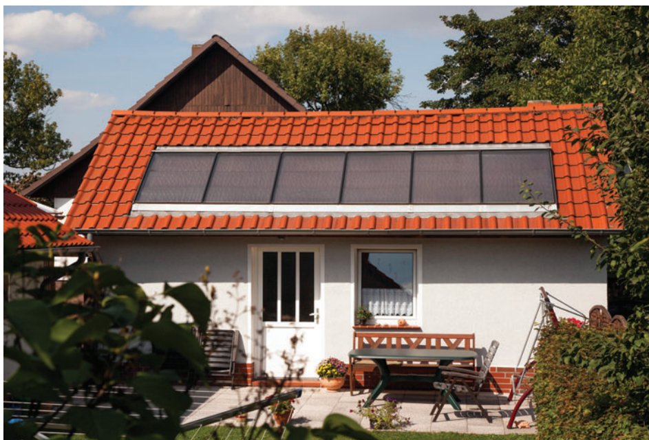
Die eigene Wärmeproduktion auf dem Dach macht sich im Geldbeutel bemerkbar: Bis zu 50 Prozent Energie können eingespart werden. Foto: © SOLVIS GmbH & Co KG
